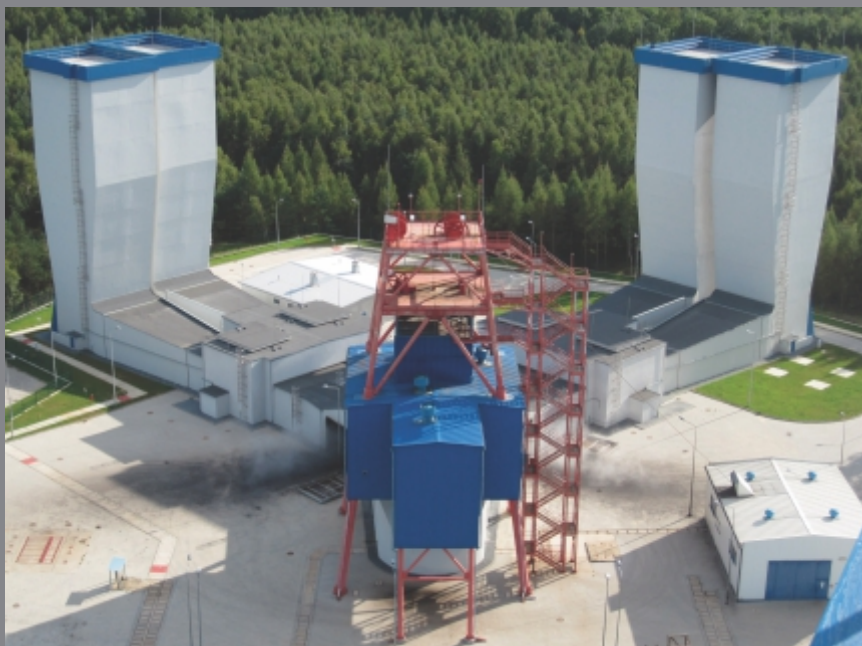
La estación de ventiladores más grande de Europa para una mina de cobre con una potencia de 16 MW donde TLT-Turbo obtuvo una emisión de ruido de 35 dBA en el límite de la instalación.
