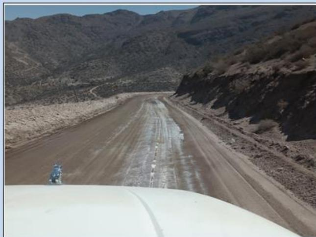
**FOTO N° 8** Aplicación de dosis de mantención tramo Patio Génova - La Verde
