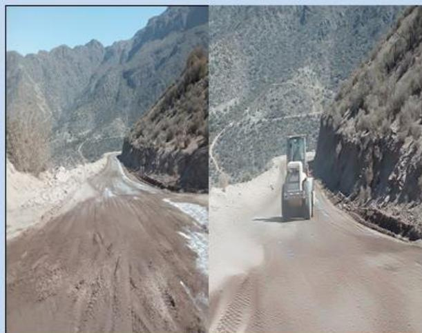
**FOTO N° 3 Humectación, con supresor de polvo y compactación de la carpeta de rodado en tramo Patio Génova - Mina La Verde. El tramo entre Acceso La Amarilla hasta La Verde no pudo ser compactada post humectación ya que rodillo presenta panne de neumáticos**
