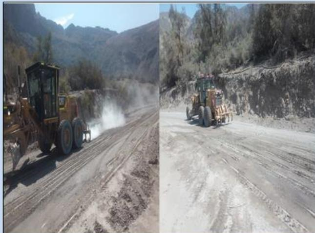
**FOTO N° 2 Escarificado de carpeta de rodado. Cabe señalar que las cuñas de la motoniveladora no contaba con las fundas adecuadas para profundizar el escarificado en tramo Acceso Mina La amarilla y tramo La Verde ( sector con mayor dureza de la carpeta de rodado**
