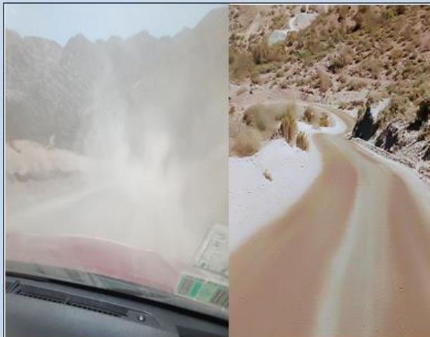
**FOTO N° 1 Emisión de polvo al momento de toma de línea base del camino y Carpeta post aplicación supresor de polvo ( Tramo Acceso Mina La Amarilla hasta Patio Génova )**
