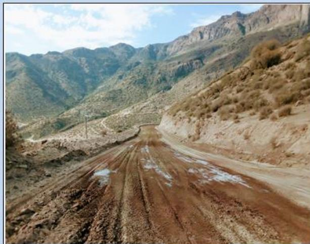
**FOTO N° 7** Detalle de carpeta escarificada tramo Patio Génova- La Verde. Este tramo, en primera instancia se escarificó y se aplicó supresor de polvo, pero NO se pudo compactar por falta de operador, quedando la carpeta sin sello durante el fin de semana, motivo por el cual se repitió el proceso de dosis de impacto.
