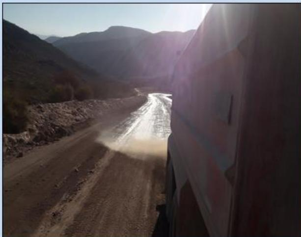
**FOTO N° 5** Detalle de regadio con camión aljibe. Cabe señalar que los aspersores liberan el supresor de forma poco pareja, dejando mayor cantidad de fluido hacia los bordes del camino.
